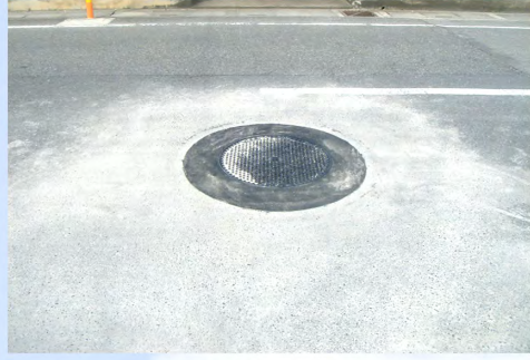
マンホール周り
