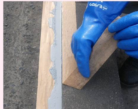
⑥ 養生テープの除去
