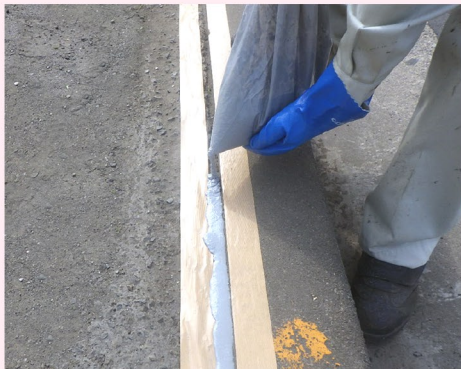
⑤ 目地部への注入
